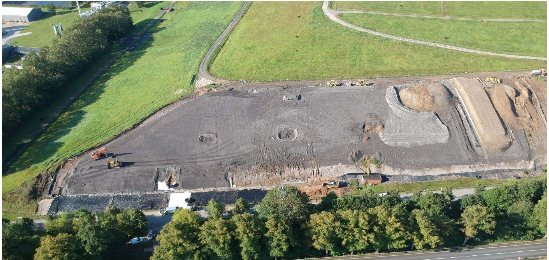
Aktuelles Baufeld zur endgültigen Oberflächenabdichtung im Altbereich der Deponie Ihlenberg.
