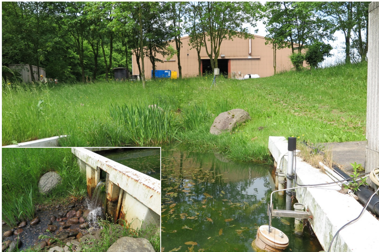
Abbildung 3-1: Sammelbecken für Permeat; Bild unten links: Probenahmestelle 1.
